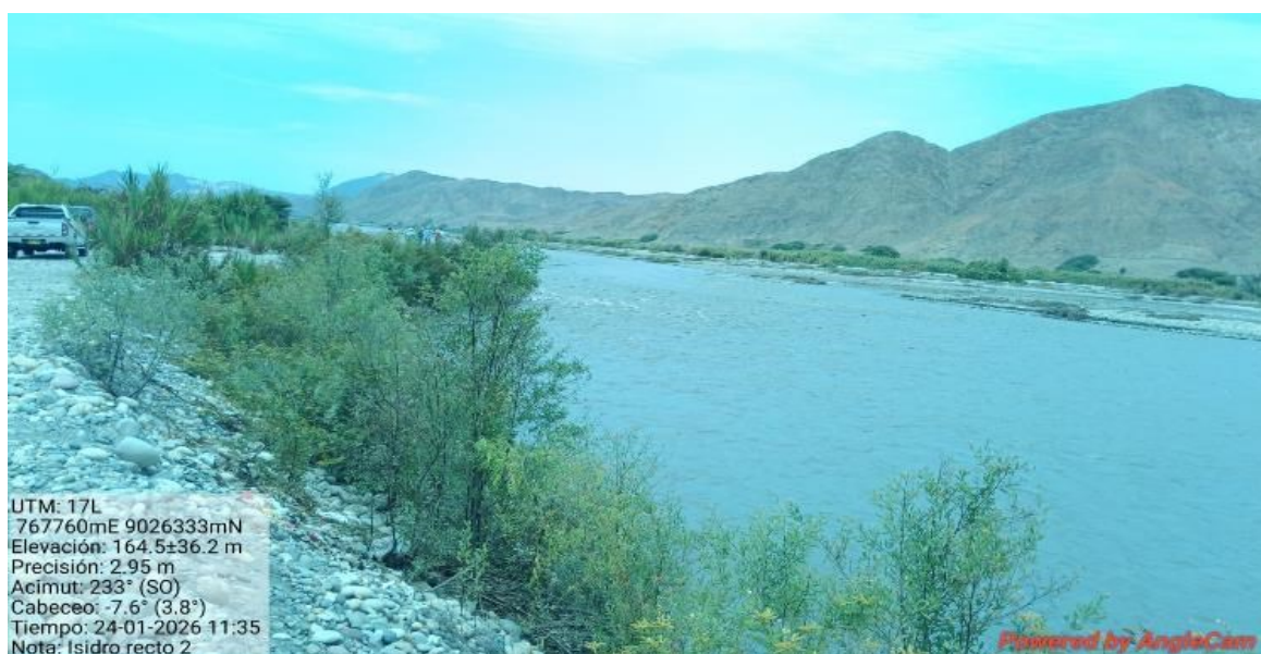
FIGURA N°03: TRAMO DEL RIO DE 200 m QUE NO TIENE PROTECCION EN LA MARGEN IZQUIERDA DEL RIO, POR TANTO PUEDE AFECTAR A AREAS AGRICOLAS, POBLACION E INFRAESTRUCTURAS HIDRAULICAS ALEDAÑAS A ESTA.
