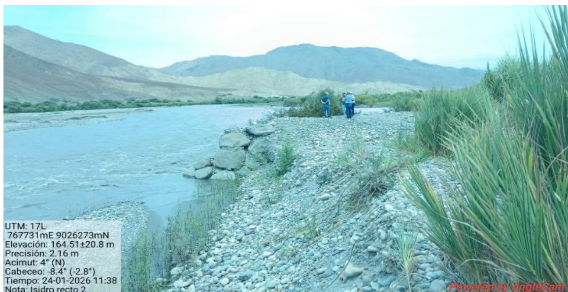
FIGURA N°02: SE APRECIA QUE LA DEFENSA EXISTENTE EN LA MARGEN IZQUIERDA DEL RIO SANTA SE ENCUENTRA DAÑADA, EROSIONADA, CON TENDENCIA A SER DESLIZADO POR EL AUMENTO DEL VOLUMEN Y AFECTAR AREAS AGRICOLAS E INFRAESTRUCTURAS HIDRAULICAS ALEDAÑAS A ESTA.
